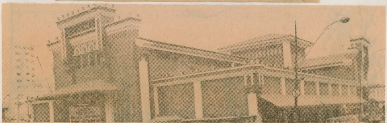
Na fachada atual, traços da personalidade do velho Mercado
