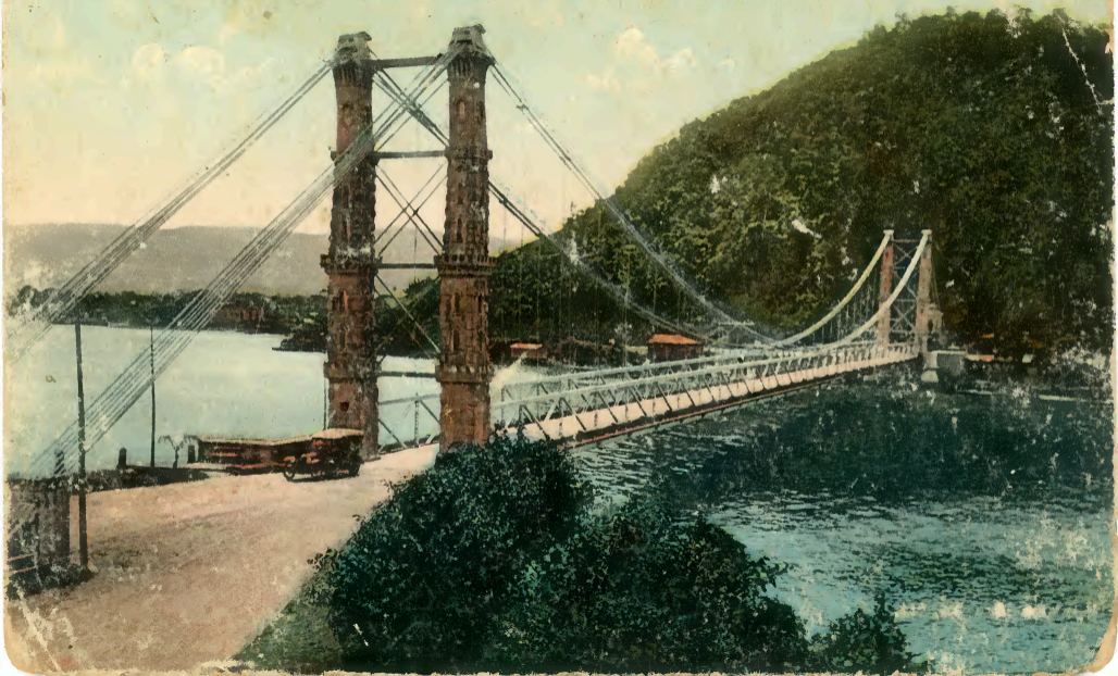
Arredores de Santos. S. Vicente. Ponte Pensil
