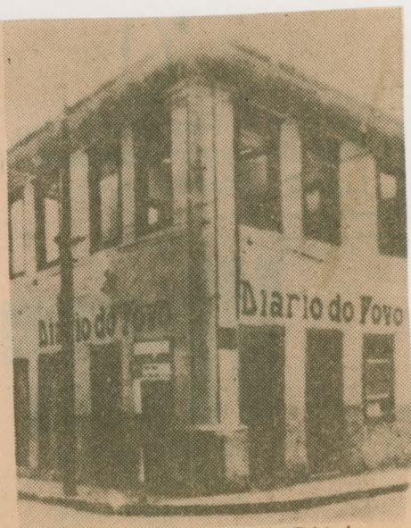
O primeiro prédio do Diário
