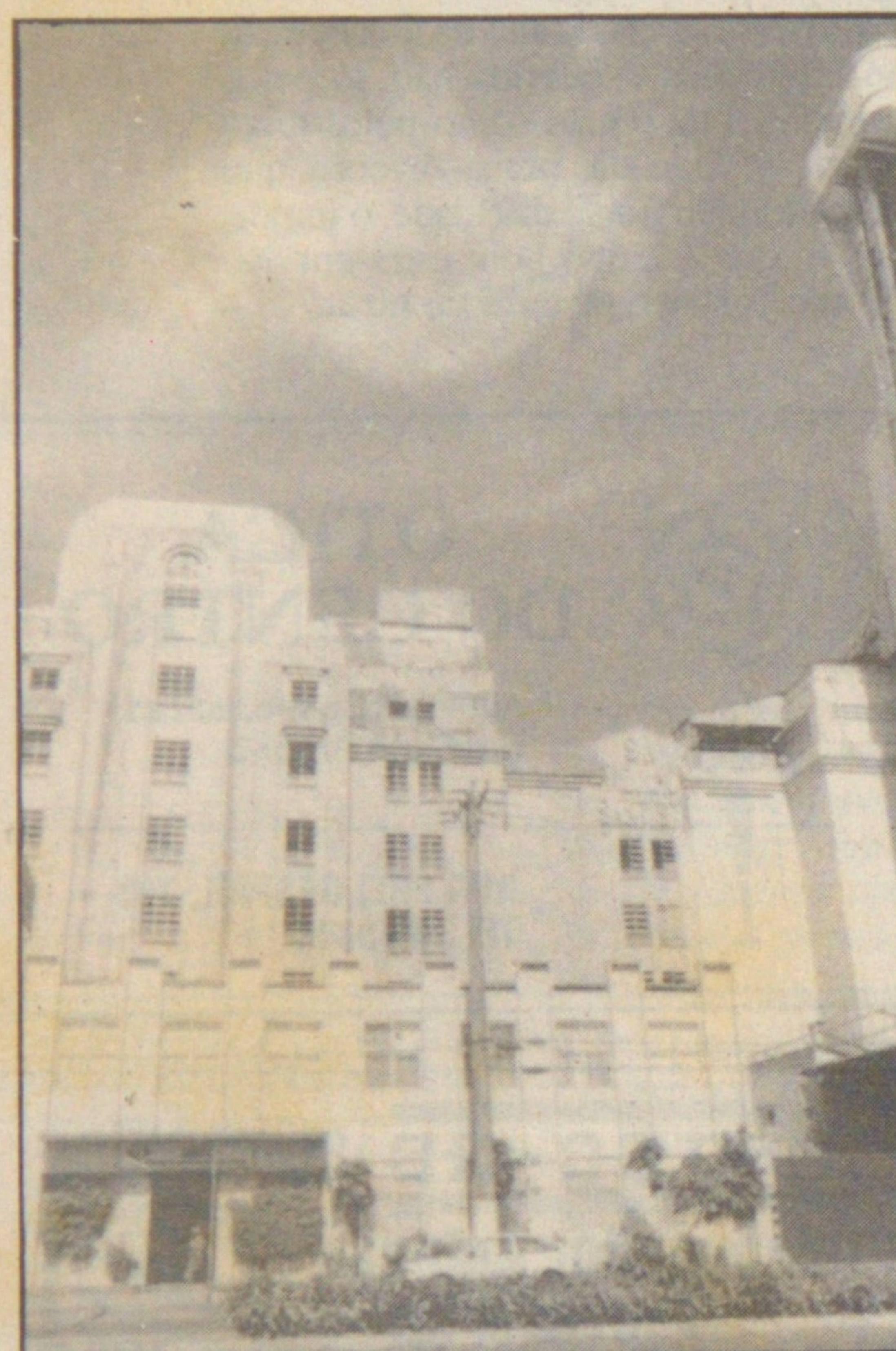
Moinho Santista, na faixa portuária, uma construção típica art-deco, das décadas de 20 e 30
