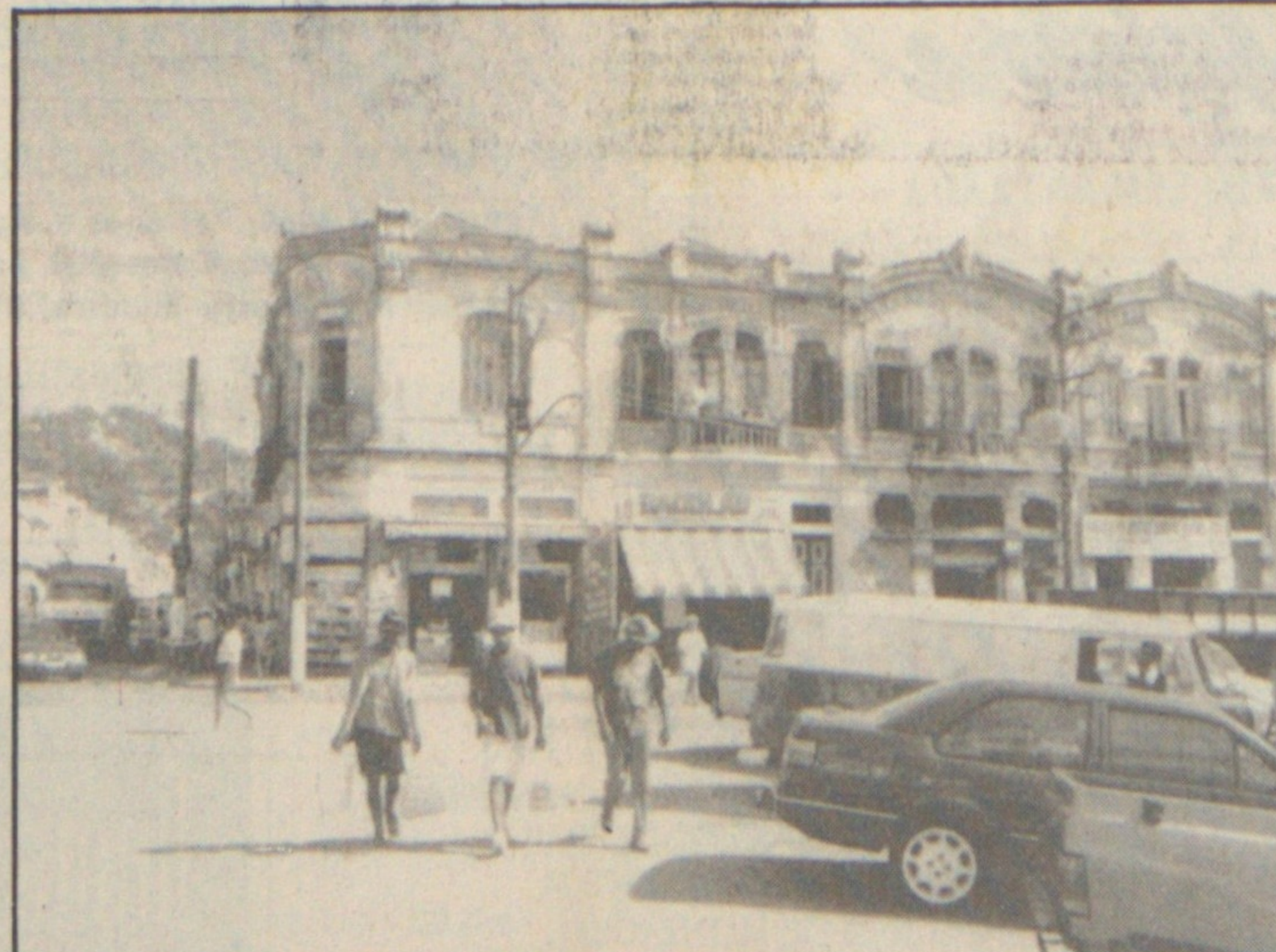
Em frente ao Mercado, na Praça Iguatemi Martins, um conjunto de casas, retrato de uma época de valorização do Centro
