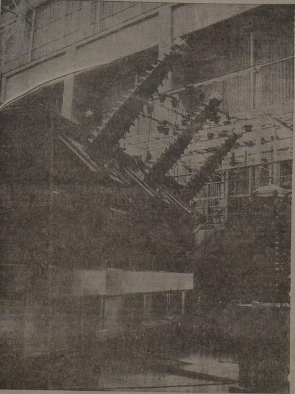
A CHESF (Cia. Hidro-Elétrica do São Francisco), adquiriu da General Electric S.A. dois transformadores cada um com a capacidade de 38/44/55 MVA, tensão de 230/138/13,8 kV, frequência de 60 HZ e um peso de 127 toneladas.
