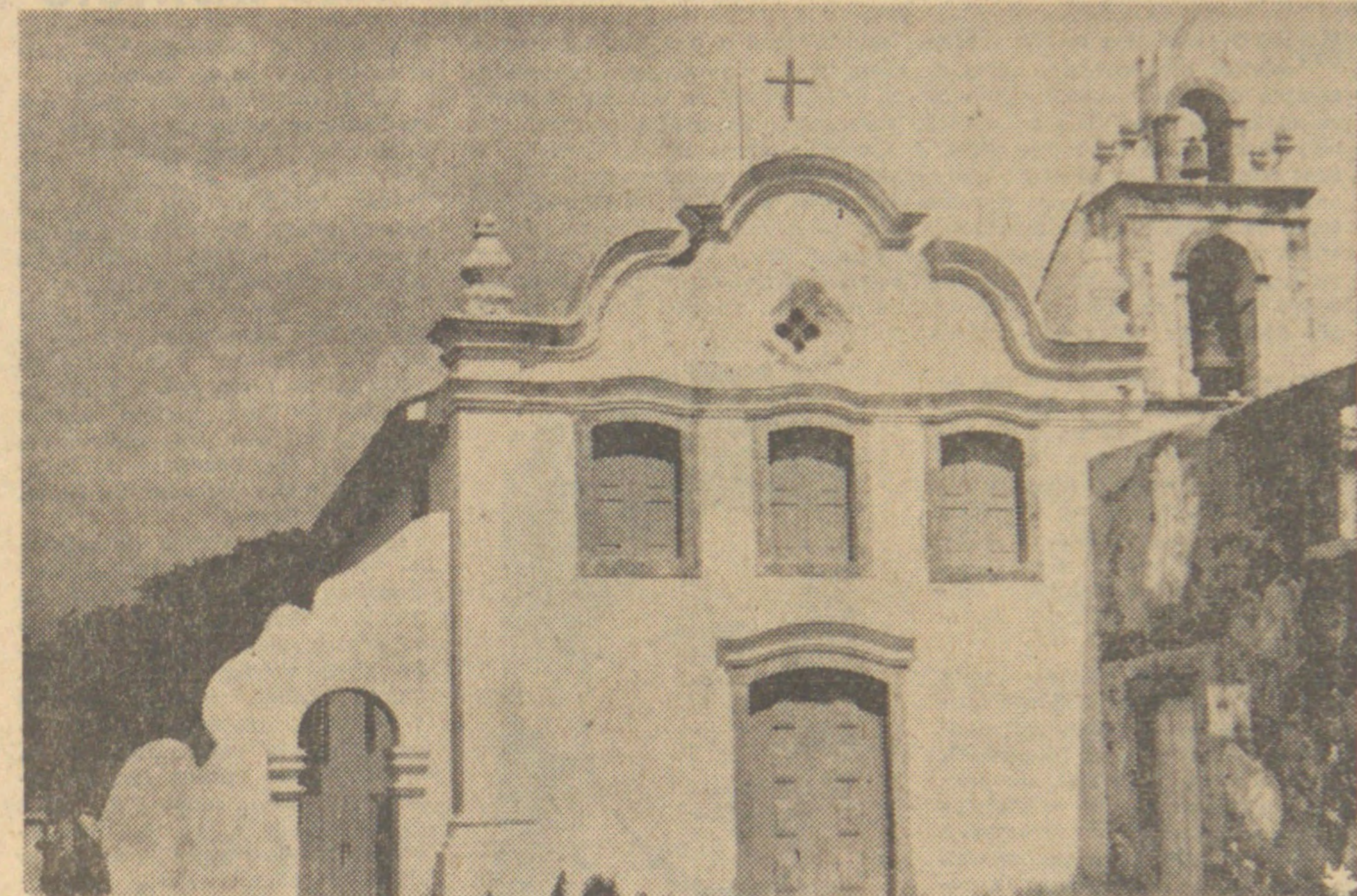
Convento de N.S. da Conceição de Itanhaem. Quase destruído por um incêndio, em 1833, foi reedificado entre 1860 e 1865.
